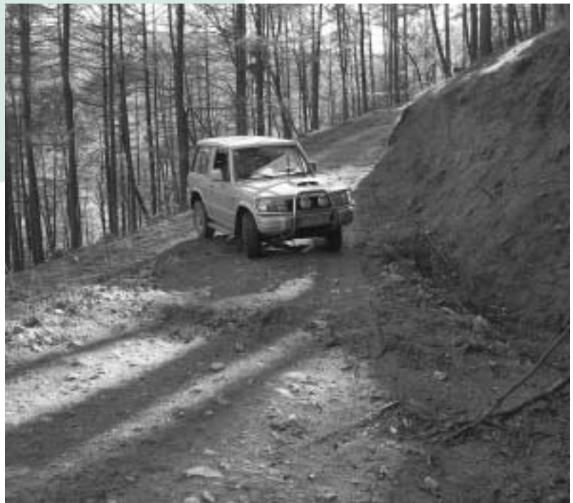
Las escorias de acería son un buen elemento para el afirmado de pistas forestales.
